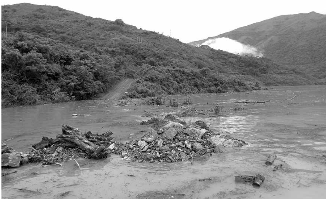
Hidroeléctrica de Hidroituango, en Colombia, genera impactos irreversibles amenazando la supervivencia de las comunidades de la región (25/05/2018).
