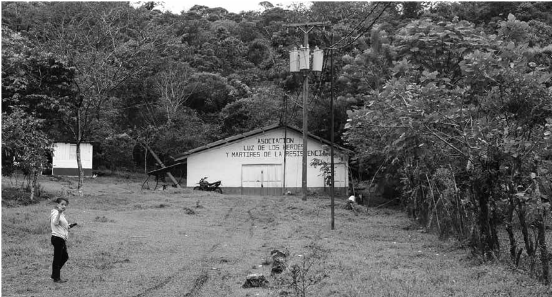
Casa de máquinas de la micro hidroeléctrica en San Miguel de Uspantán, Guatemala.
